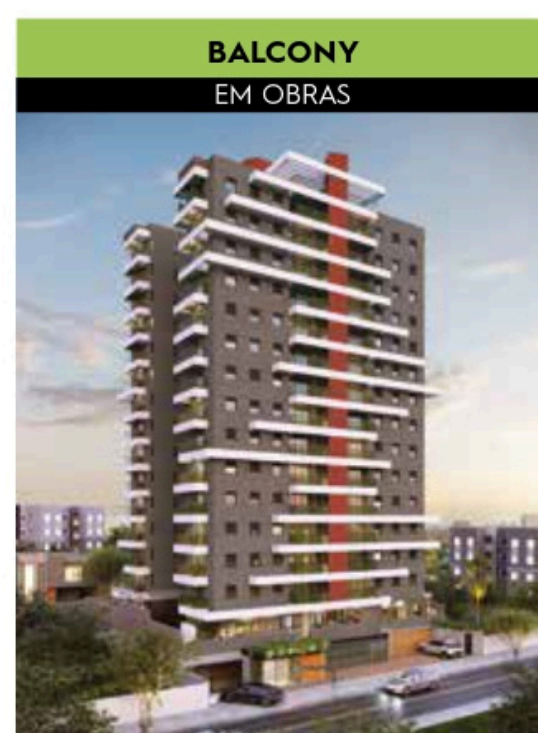
BALCONY EM OBRAS R. ANDARAÍ, 366 V. FLORESTA / STO. ANDRÉ
